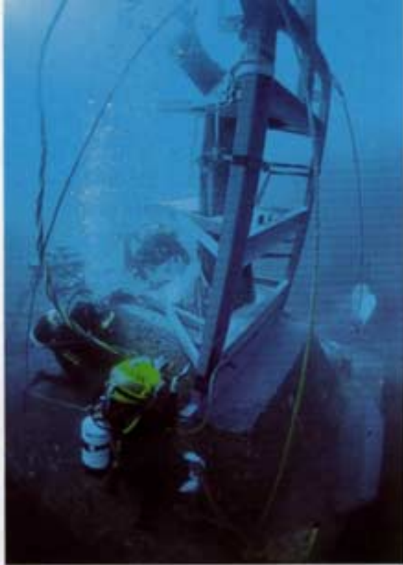
Nelle foto le varie fasi del taglio del basamento e dell'imbracatura della statua che, per essere portata in superficie, viene sistemata in posizione orizzontale.
